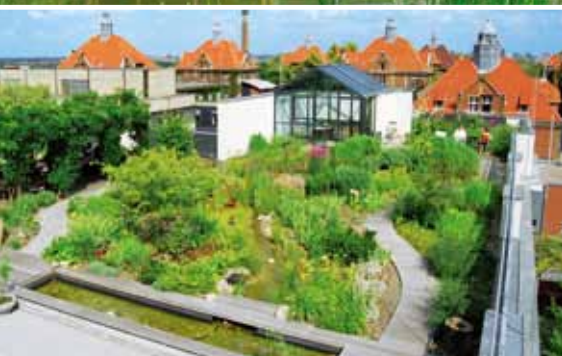
Użytkowy ogród na dachu z tarasem
