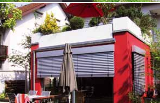
Donice z roślinami jako zabezpieczenie obrzeży dachu
